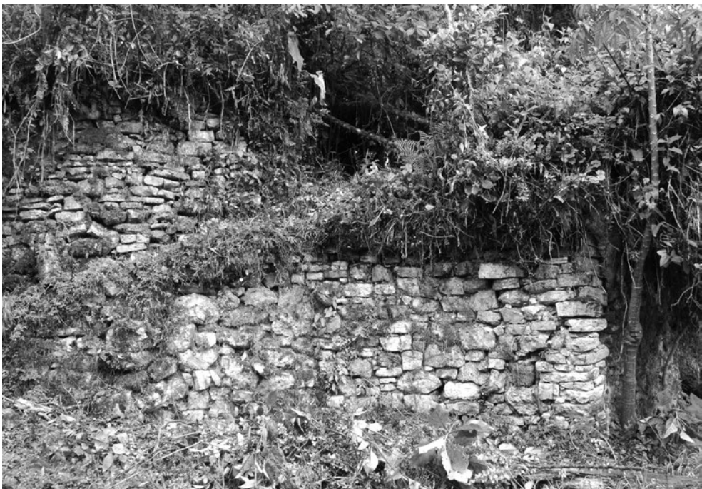
Figura 8. Rampa al sector Chachapoya restringido en Purun Llacta de Soloco (foto por J. M. Crandall).
