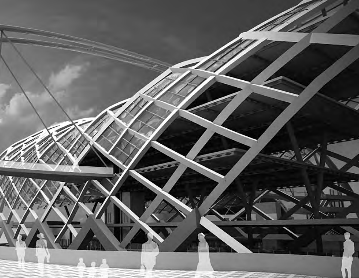
Render exterior del proyecto. Se muestra el sistema estructural “Diagrid”, que conforma el recubrimiento de la estación intermodal.
