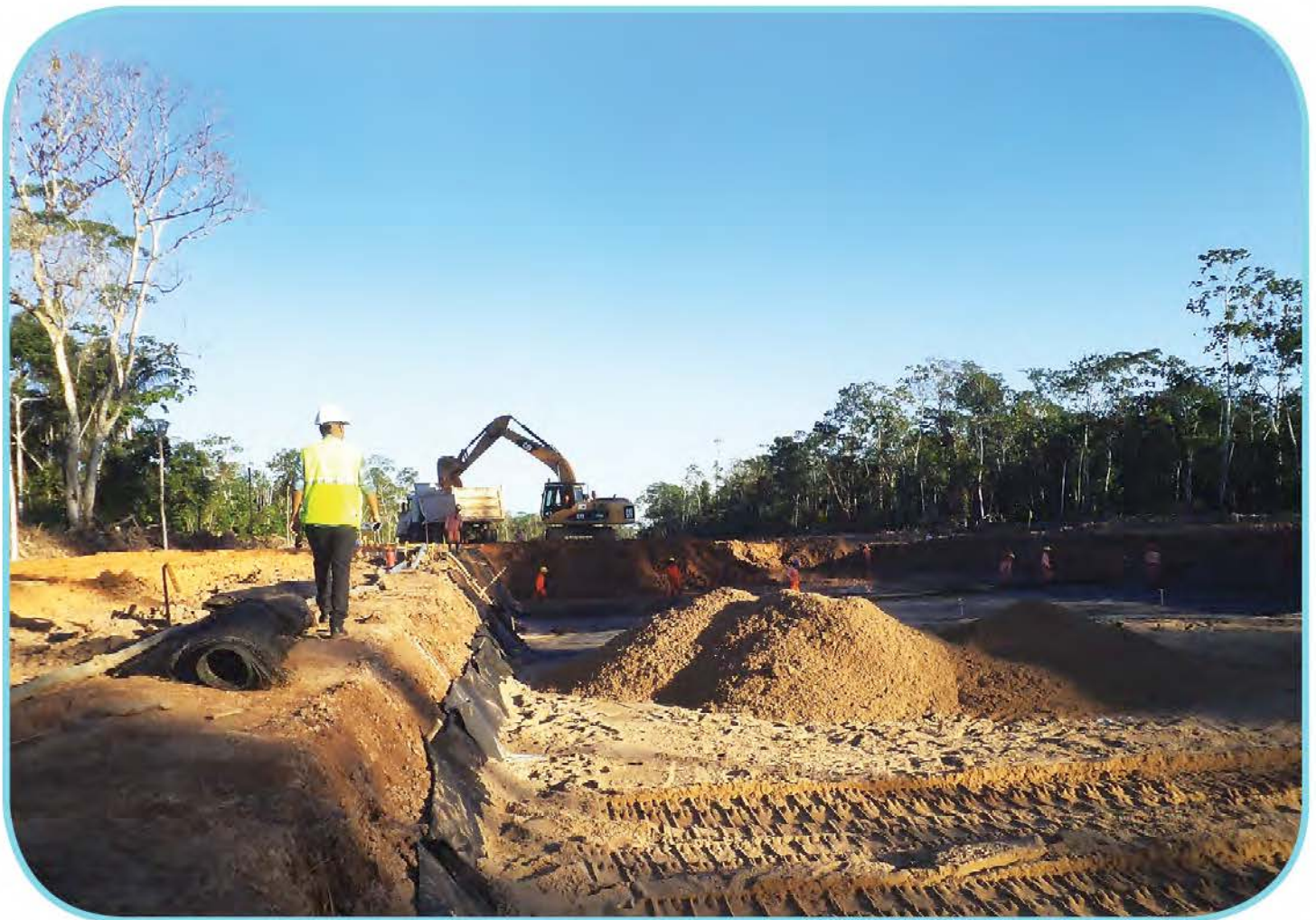
Fig. 1: Trabajos en Sub Tramo III del Acceso al Nuevo Puerto de Yurimaguas (Zona Inundable).
