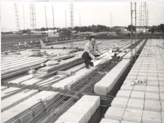
Primer techo del Pabellón A, 1960.
