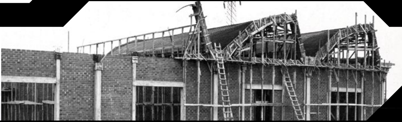
Construcción del Pabellón C (laboratorios), 1961.
