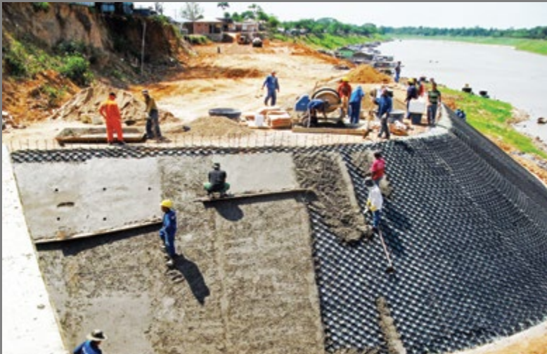
Control de Erosión en Canales
