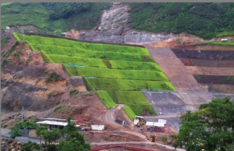
Control de Erosión en Taludes
