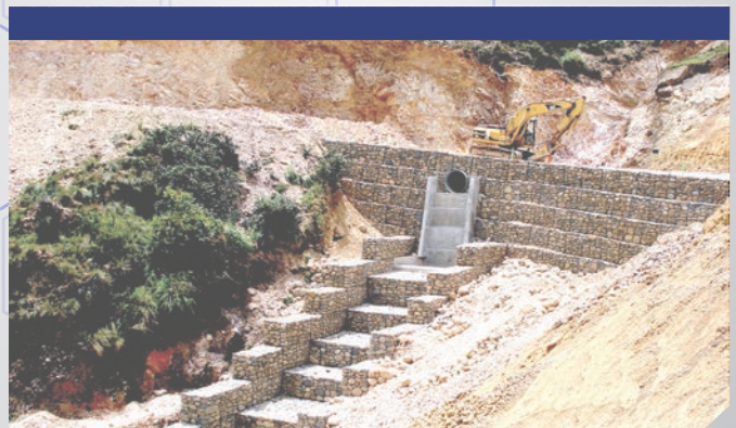
Protección de alcantarilla Carretera Shiran - Huamachuco
