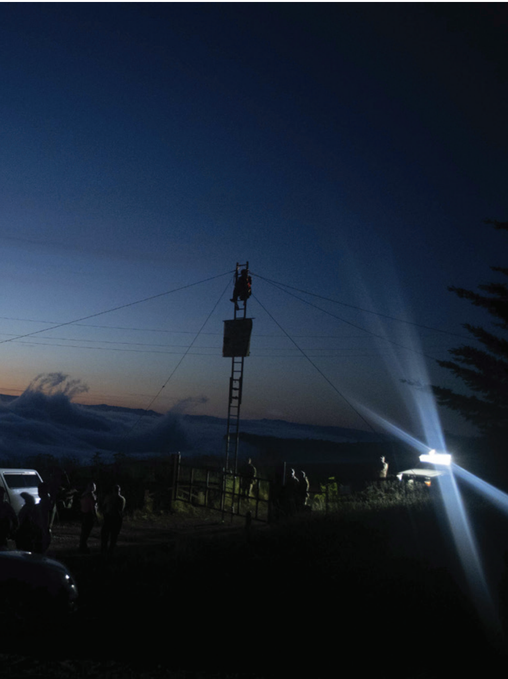
Un activista bloquea un camino de trabajo al amarrar una escalera a la entrada principal de este de tal forma que no pueda ser desplazado sin poner en peligro su integridad. Junio 2019
