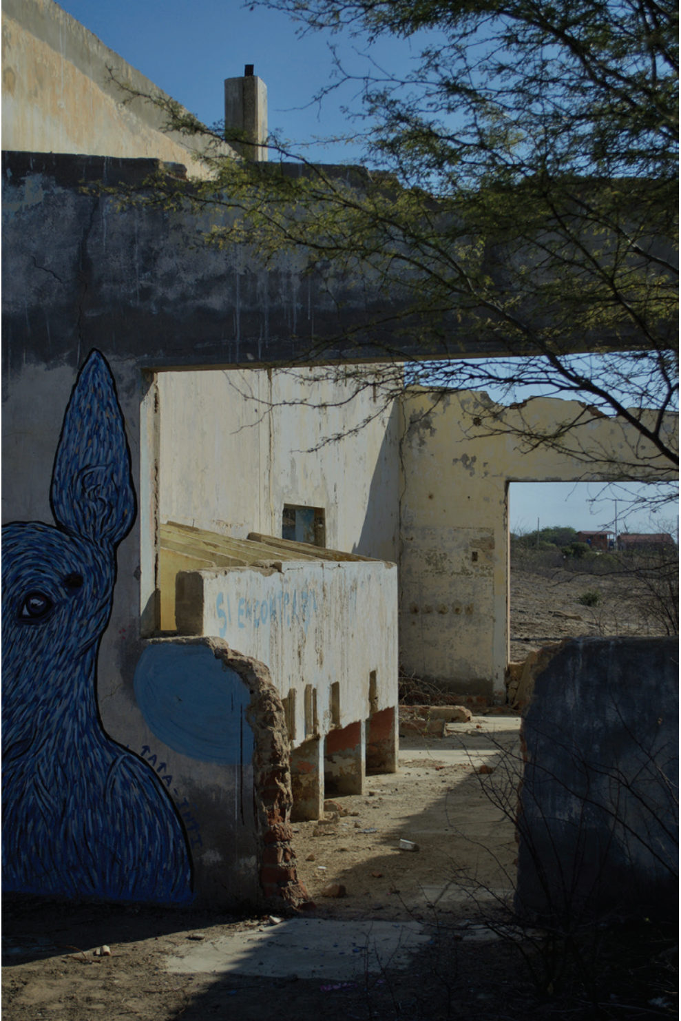
Vista interior del antiguo barrio militar en la playa Piscinas, ahora en ruinas
