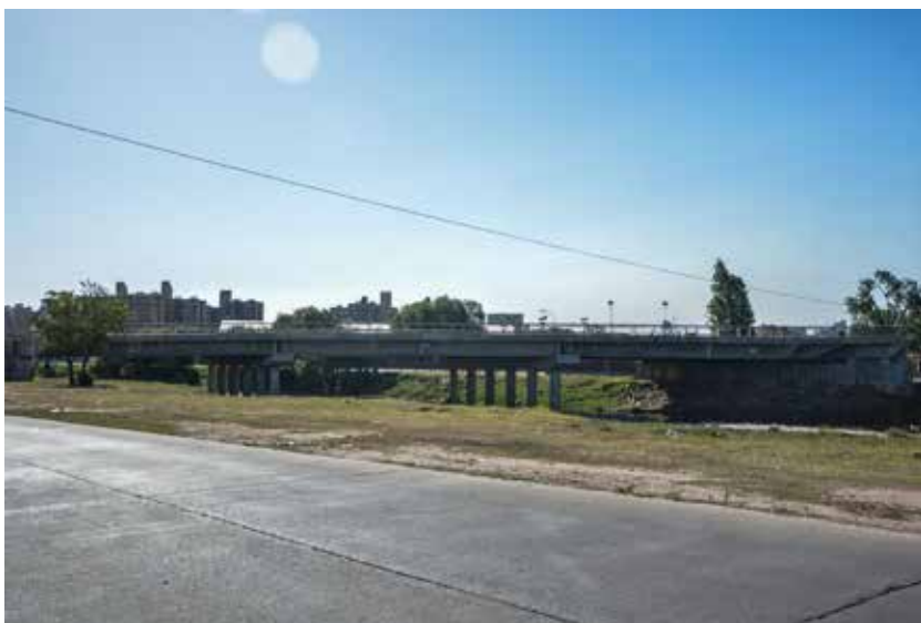
Figura 3. Puente Letizia, construido en 2017 sobre el río Suquía, pero sin bajar a las márgenes sur y norte.
