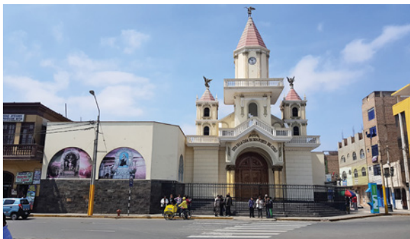
Antes y después. Iglesia Matriz de Huacho del arquitecto José García Bryce.
