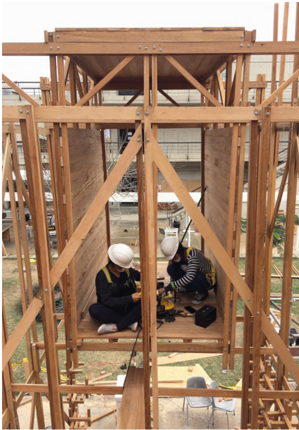
Construcción de un espacio colgado de dos vigas tijerales.
