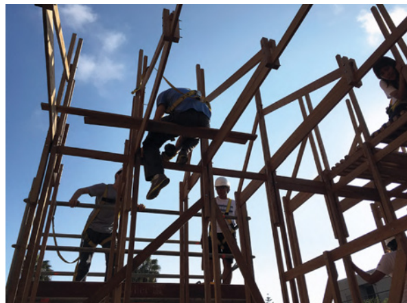
Construcción de las macetas adosadas a la estructura matriz.
