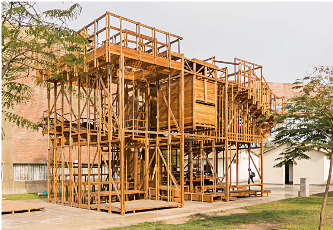
Proyecto finalizado luego de dos semestres (2017-1 y 2017-2), ubicado en el patio de la Facultad de Arquitectura y Urbanismo (PUCP). Fotografía: Diego Lama.
