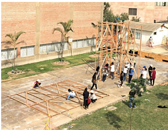
Fabricación y armado de la estructura matriz.
