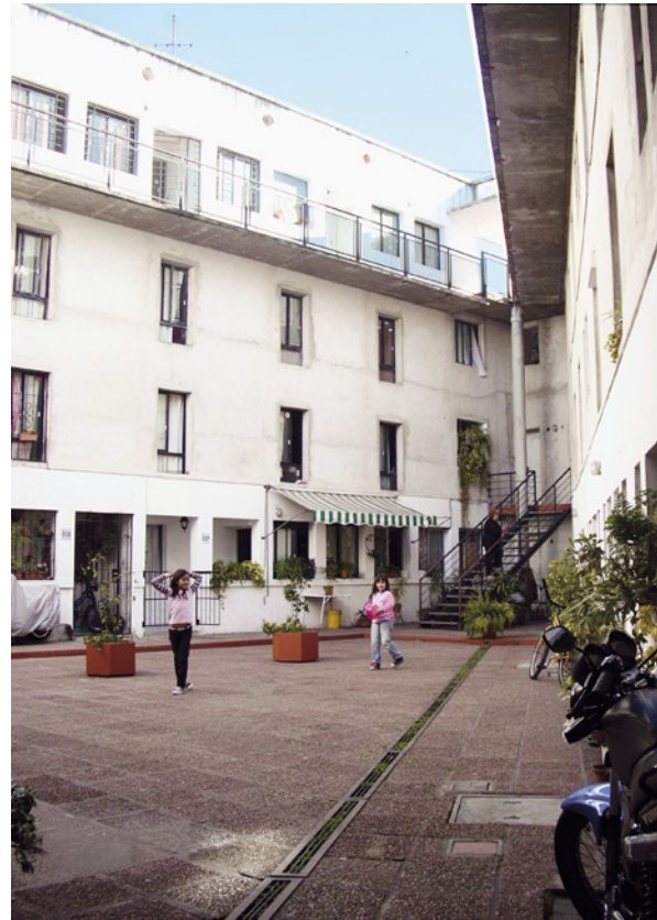
Cooperativa de viviendas de ayuda mutua COVICIVI 1, en Montevideo. Interior.
