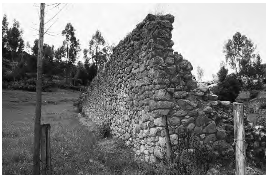
Fig. 2. Sector A, El Palacio. Muro norte de la estructura rectangular (vista desde el oeste) (foto: Shinya Watanabe).
