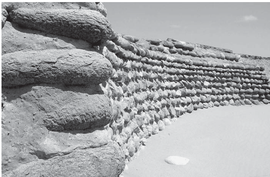
Fig. 9. Detalle del muro oeste de la plaza circular (foto: Alejandro Chu).
