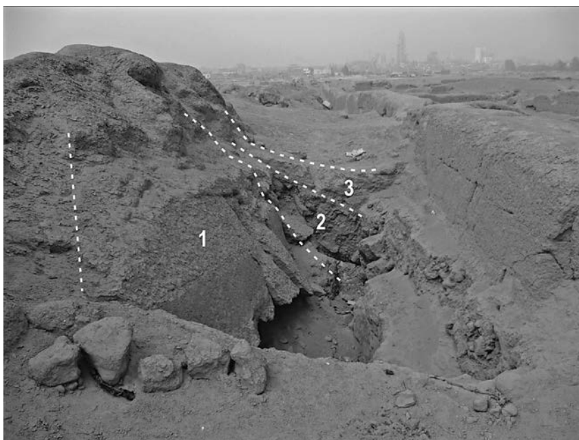
Figura 4. Colapsamiento de paredes que están rellenando parcialmente uno de los pasadizos en el lado oriental del Conjunto Tello (Cajamarquilla). 1) Pared colapsada; 2) Bloques de tapias colapsados post sismo; 3) Materiales de erosión que rellenan las estructuras colapsadas.
