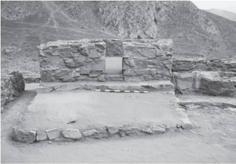
Fig. 7B. Sector II. Palacio del curaca principal. Vista de la entrada al ushnu desde el patio central del palacio después de los trabajos de consolidación (Foto: G. Presbítero).
