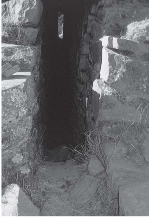
Fig. 7. El espacio detrás del muro de contención de la Terraza 1.
