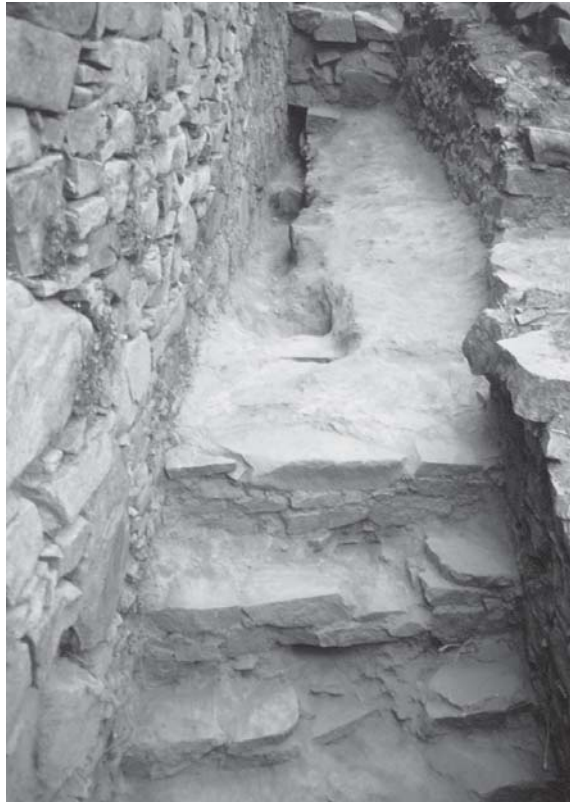
Fig. 10. El canal que pasa al pie norte del muro de contención de la Terraza 2.
