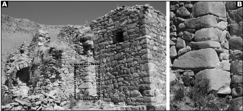
Figura 8. Fachada de la iglesia de Mawchu Llacta (A), con el detalle de bloques finos de estilo inkaico incorporados (B).
