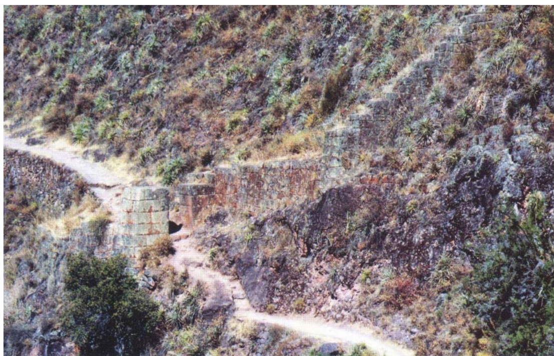
Fig. 22. Detalle de la muralla con portada (Foto: T. Kusuda).
