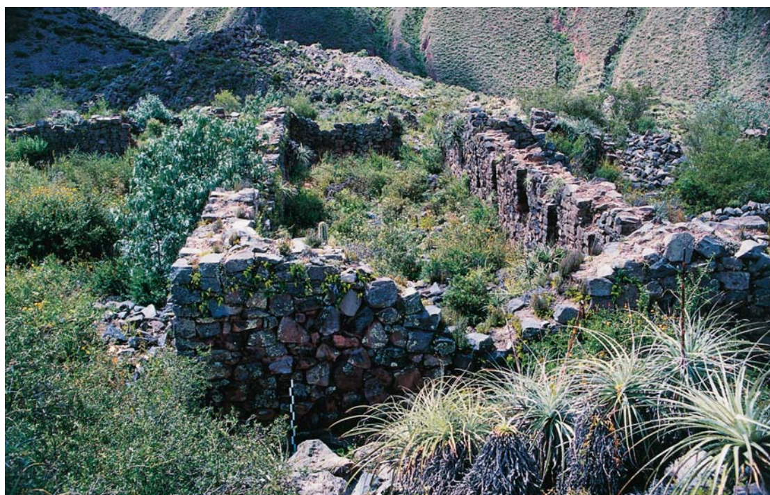
Fig. 4. Kallanca N.º 2, recinto de planta cuadrangular de 22,30 metros de largo y 8,20 metros de ancho. Tiene tres vanos de acceso y siete nichos de forma trapezoidal.
