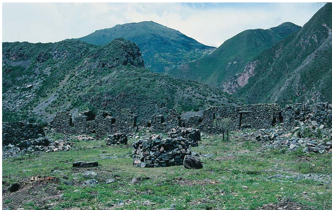
Fig. 3. Kallanca N.º 1, recinto de planta rectangular de 33,30 metros de largo y 11,20 metros de ancho. Presenta cuatro vanos de acceso de forma trapezoidal, siete ventanas y, al interior, 17 nichos de forma trapezoidal.
