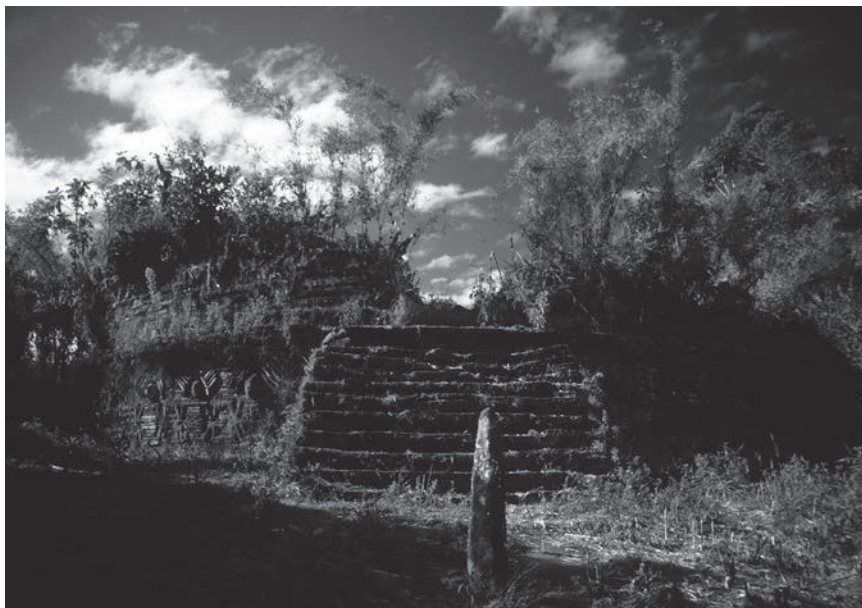
Figura 4. Vista frontal del Edificio 1, Gran Pajatén (foto de W. B. Church 1985).
