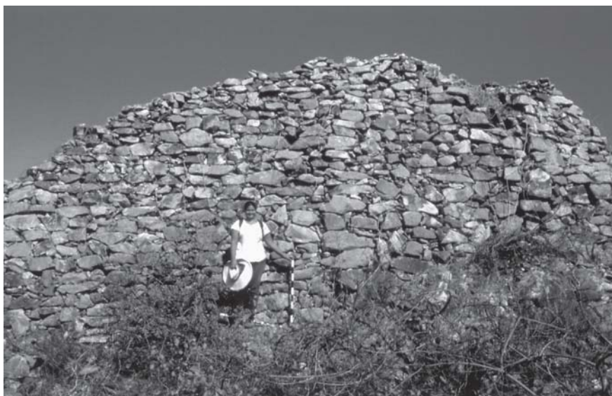
Fig. 7. Vista de la cara externa del muro perimétrico 4.
