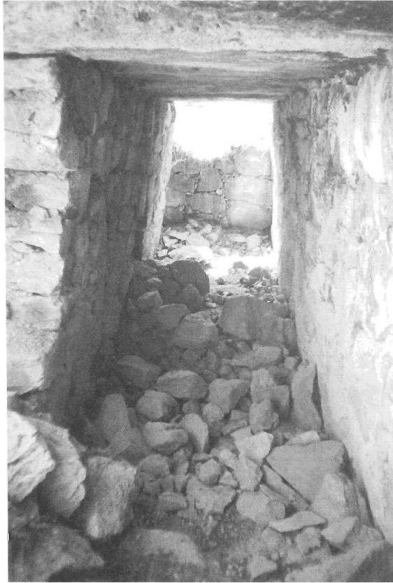
Fig. 38. Huacaurara. Galería con techo megalítico en Kichkacorrall o Callejonqasa.
