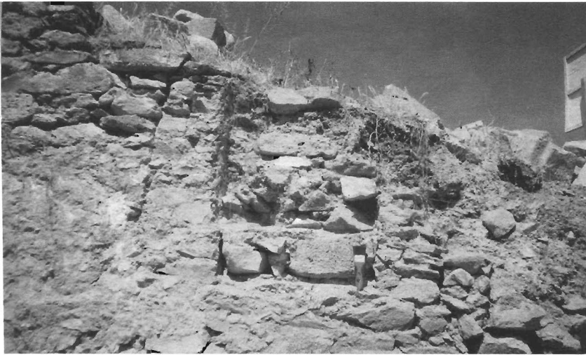
Fig. 16. Monqachayoq. Detalle de acceso remodelado en varios momentos de ocupación, lado sur del Nivel 1. Área con estructuras subterráneas.
