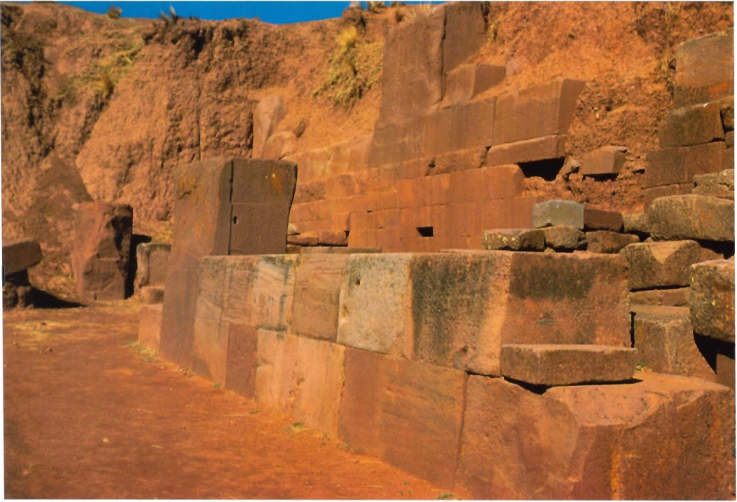
Fig. 6. Vista del muro autosostenido.
