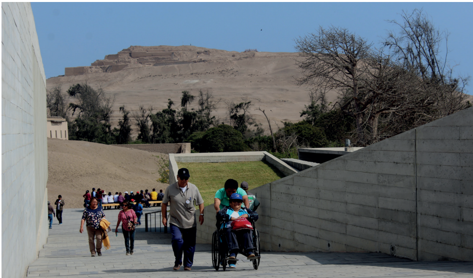
Figura 8. El Museo Pachacamac cuenta con una serie de rampas que facilitan la circulación de las personas con discapacidad motora (fotografía: Museo Pachacamac).
