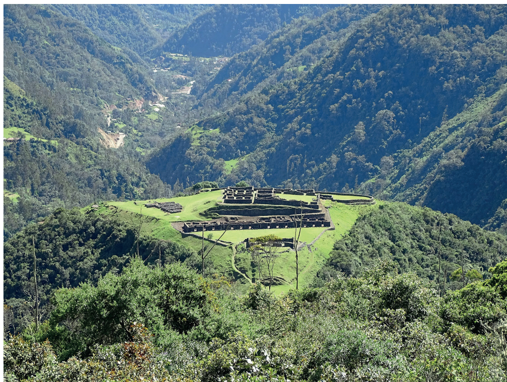
Figura 2. Vista de Vitcos desde el sur, sobre Hatun Moqo (fotografía: J. Valencia Cordova).
