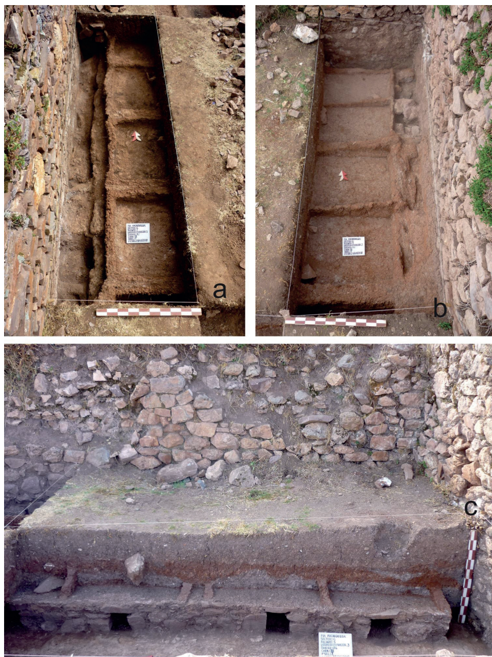
Figura 13. a y b. Taques con divisiones de barro, c. Ductos de ventilación de los taques (fotografías: Víctor Ccahuana).
