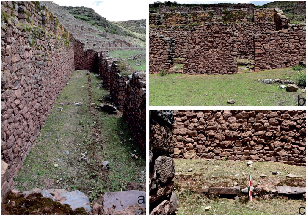
Figura 12. Depósito en Machuqolqa: a. Vista del interior y del espacio del taque, b. Vanos de acceso del depósito, c. Detalle de los conductos de ventilación del taque (fotografías: Carlos Delgado González).
