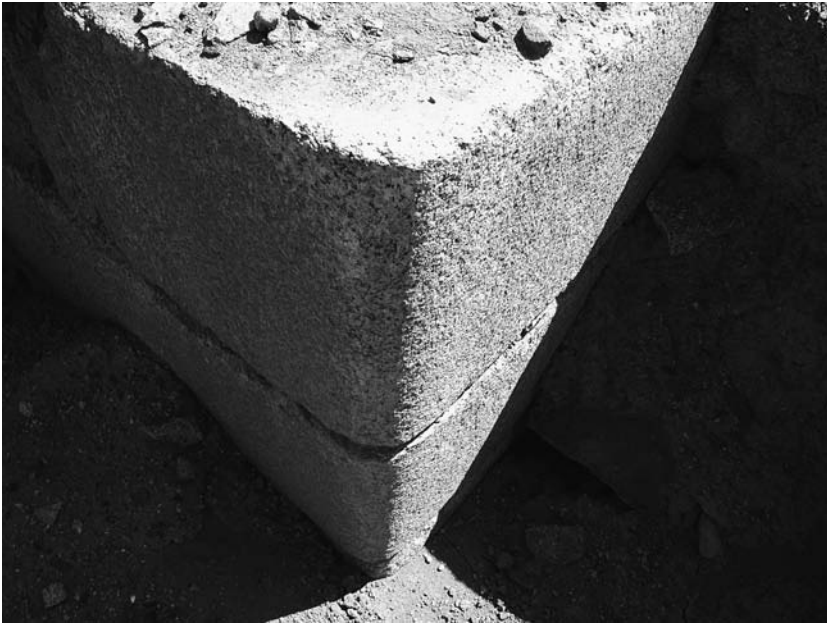
Fig. 7. Detalle del acabado de una de las rocas megalíticas utilizadas en la construcción de las portadas y las esquinas del área monumental (foto: Hugo Ikehara).
