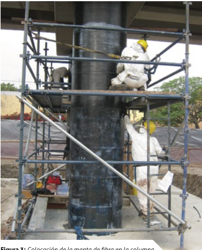
Figura 3: Colocación de la manta de fibra en la columna
