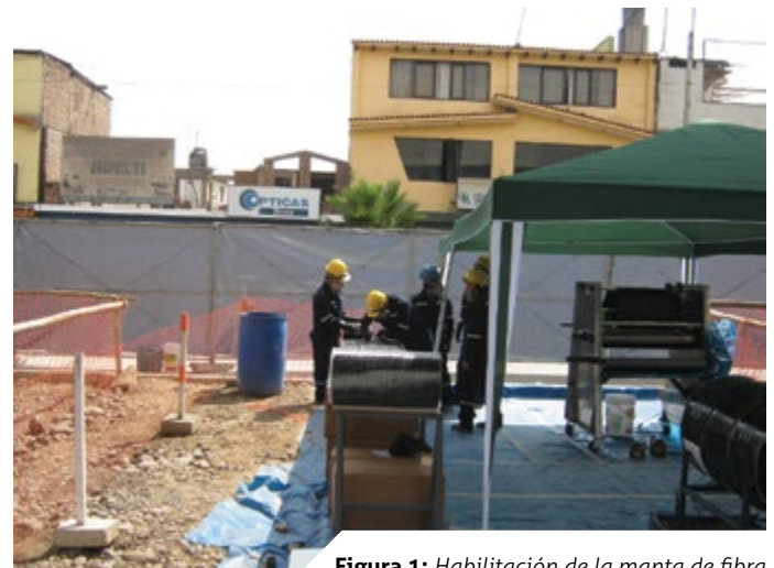
Figura 1: Habilitación de la manta de fibra empleando la máquina Saturadora
