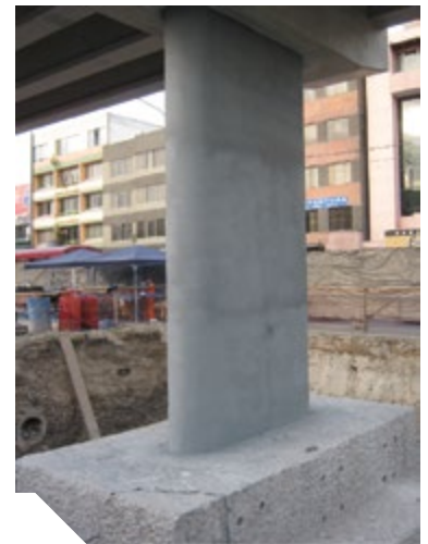
Figura 5: Columna ya reforzada
