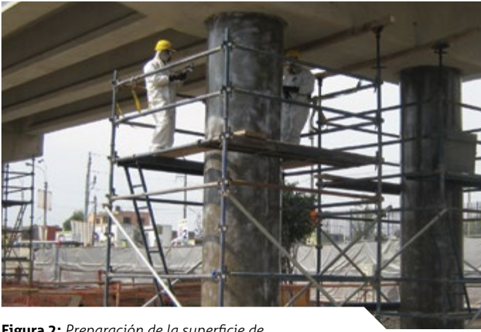
Figura 2: Preparación de la superficie de columna a reforzar con primer saturante
