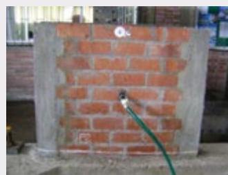
Fig.12. M4-Fase 2. Grieta en la base.
