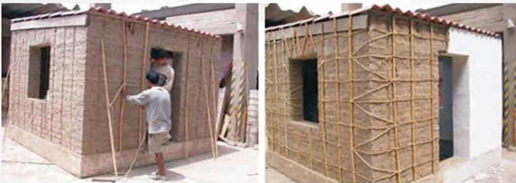
**Figura 2.2. Muro de adobe reforzado con malla natural (PNUD, 2008)**
