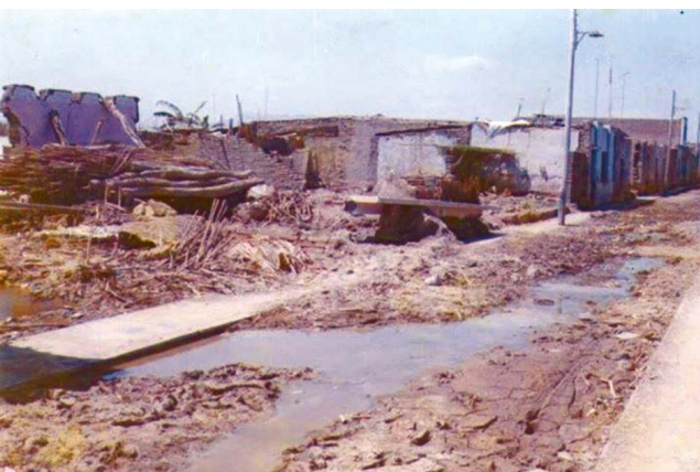
Figura 4/ Las zonas más vulnerables son habitadas en su mayoría por personas de escasos recursos. La construcción de su vivienda normalmente es de adobe o quincha que son susceptibles al agua. Chiclayo, 1998
