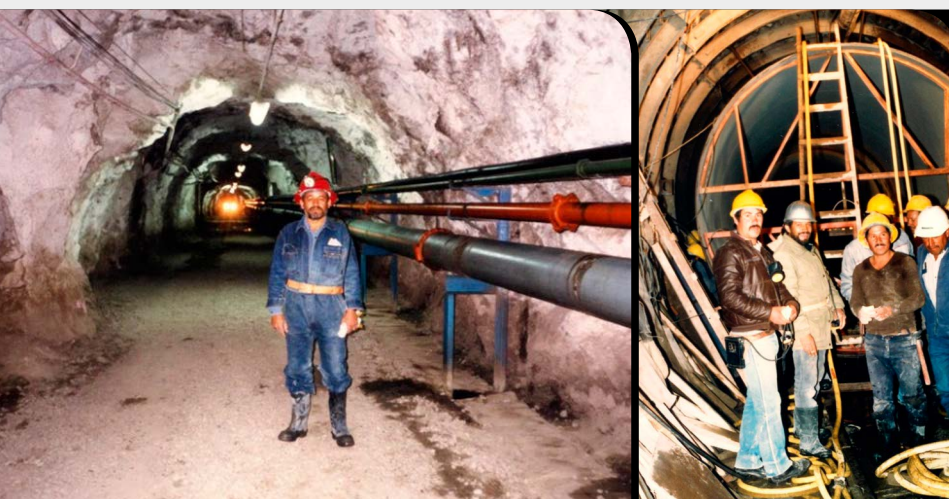
TÚNEL DE CONDUCCIÓN C.H. CARCANI V AREQUIPA PERU
