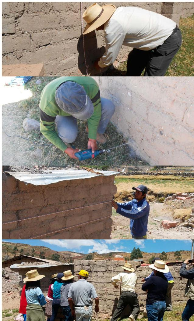
Figura 6 / Sesión práctica de colocación de cuerdas horizontales y verticales en muro de cerco
