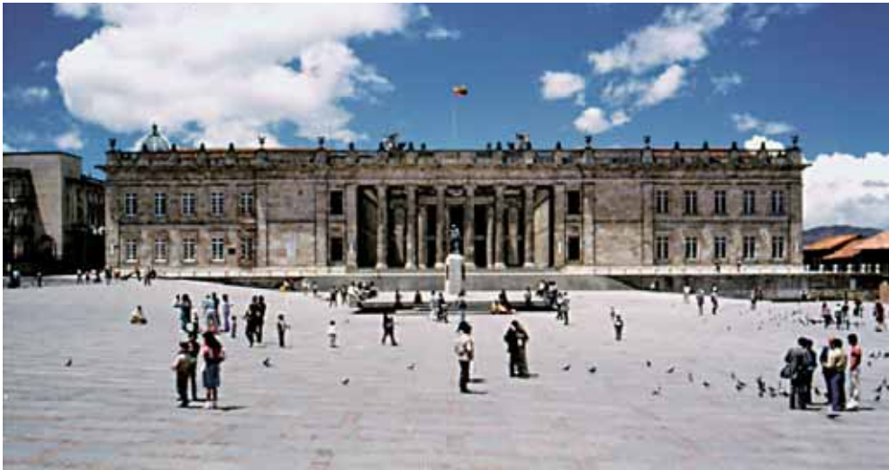
Capitolio Nacional de Colombia, estado actual.
