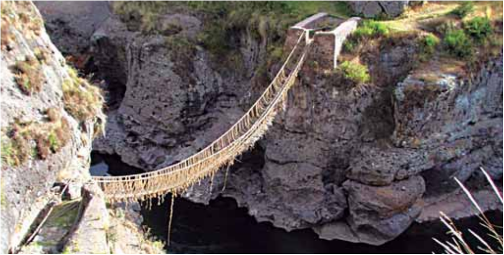
Puente de criznejas sobre el Apurímac. Foto: Alejo Gutiérrez Viñuales. Colección Cedodal.
