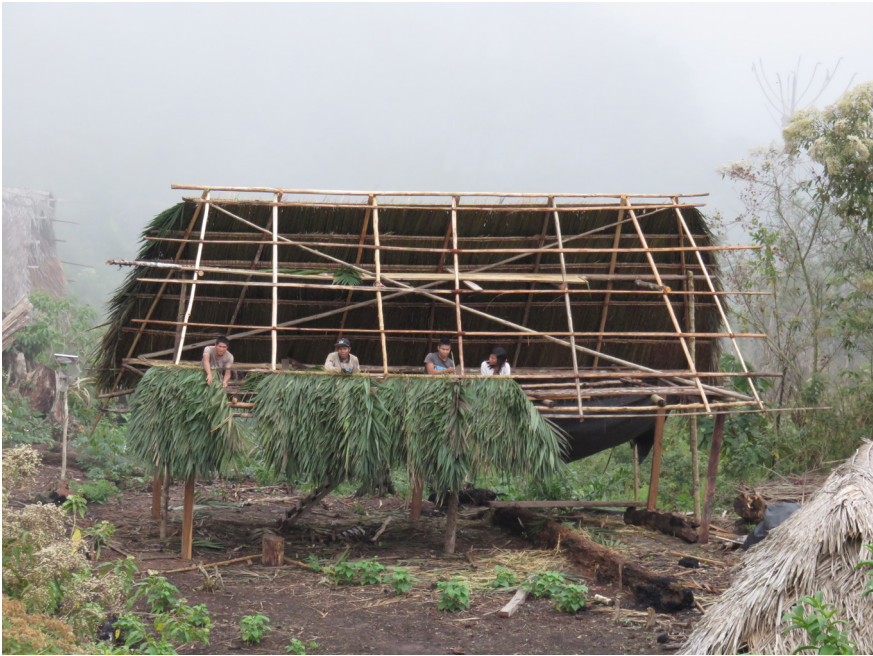
► Figura 5 Proceso de construc- ción del techo de una vivienda tradicional asháninka.
