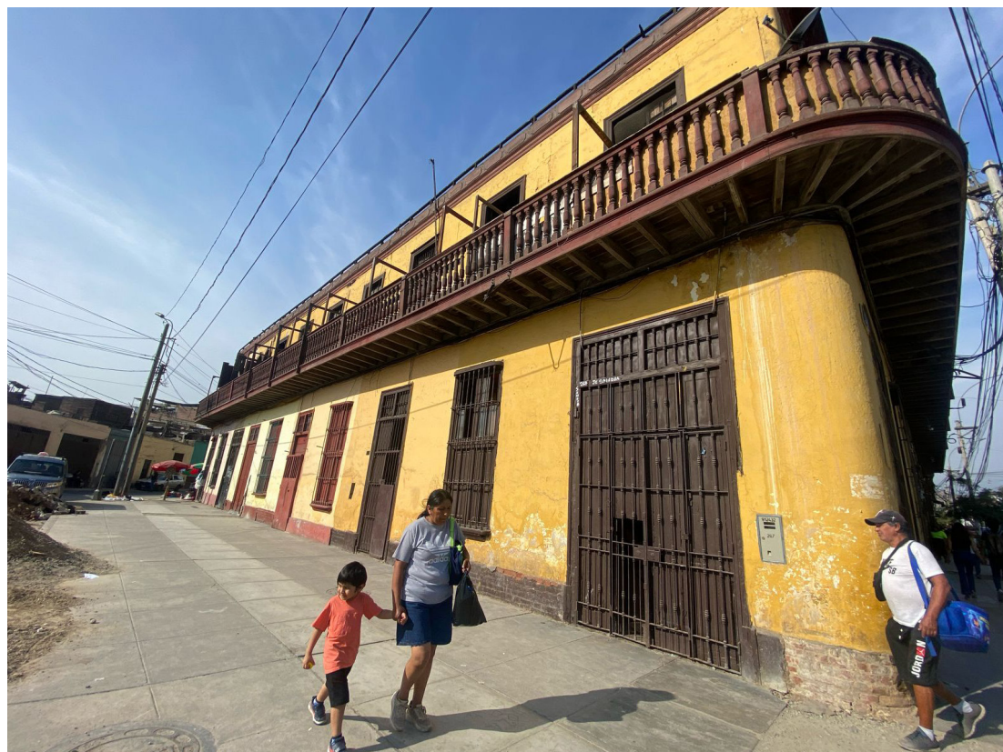
► Figura 3 Imagen de inmueble del Caso 1, avenida Carlos Zavala. Fotografía: Pro- lima, abril de 2025.
