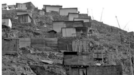
Figura 14. Derrumbes en terraplenes. En la zona se observan terraplenes mal conformados que terminan en un muro seco (pirca), y sin ningún tipo de amalgamación entre los fragmentos de roca que los componen. Estas estructuras podrían colapsar y originar derrumbes.
