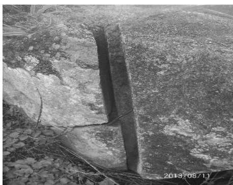
Figura 8. Diaclasa o junta del macizo granítico. Este se clasifica como del tipo 'Junta abierta sin relleno'. Presenta una abertura de 8 cm.
