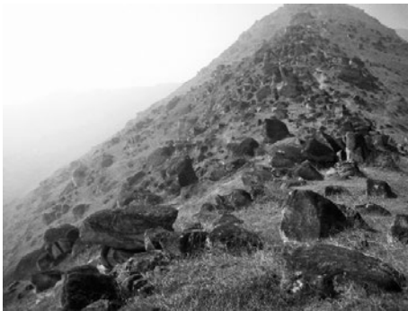
Figura 10. Caos de bloques graníticos, en estado suelto, presentes en la ladera del cerro. Estos representan potenciales riesgos geológicos, que podrían generar caídas de rocas.
