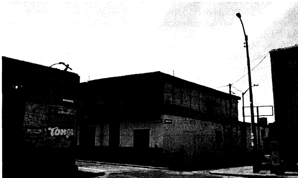
Foto n.º 17. Las casonas en San Pedro de Lloc son numerosas y denotan un pasado de bonanza económica. Lamentablemente, muchas de estas casonas están en estado ruinoso y se encuentran en peligro de desaparecer.
