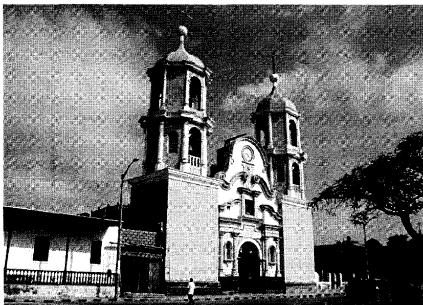
Foto n.º 8. La iglesia de San Pedro de Lloc fue construida en el siglo XVIII y se ha mantenido con reconstrucciones después de fenómenos ambientales como temblores o lluvias. Últimamente, se han introducido modificaciones con materiales ajenos a su estructura original con el beneplácito de las autoridades locales. Es una pena que este patrimonio sea maltratado.
