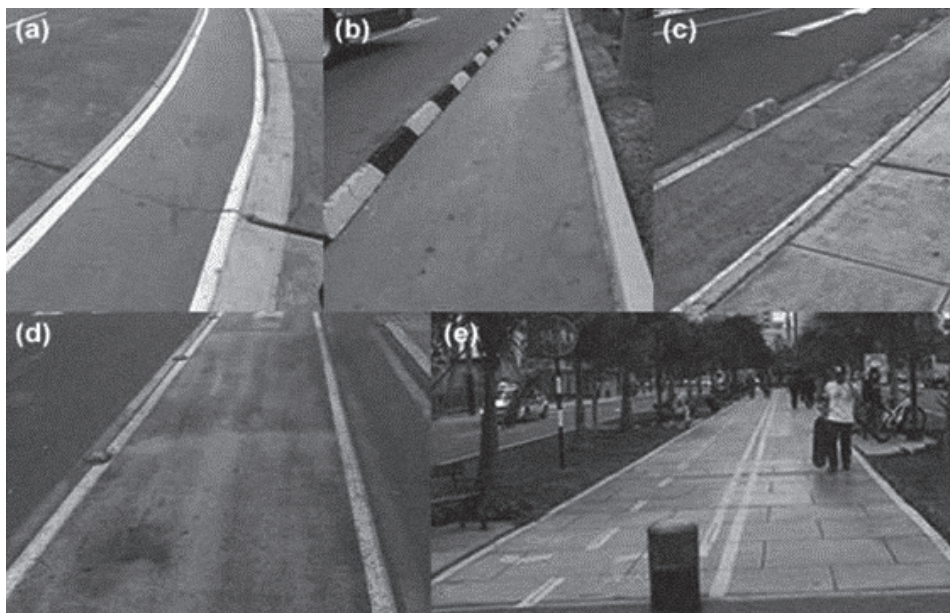
Figura 6. Ejemplos de ciclovías en el distrito de Miraflores, tipología, elemento segregador y sentido de vía: a., Ciclocarril, Pintura, Unidireccional; b., Ciclovía, Bordillo continuo, Unidireccional; c., Ciclovía, Bordillo intercalado, Unidireccional; d., Ciclovía, Ojos de gato, Unidireccional; e., Cicloacera, Sardinell, Bidireccional.
