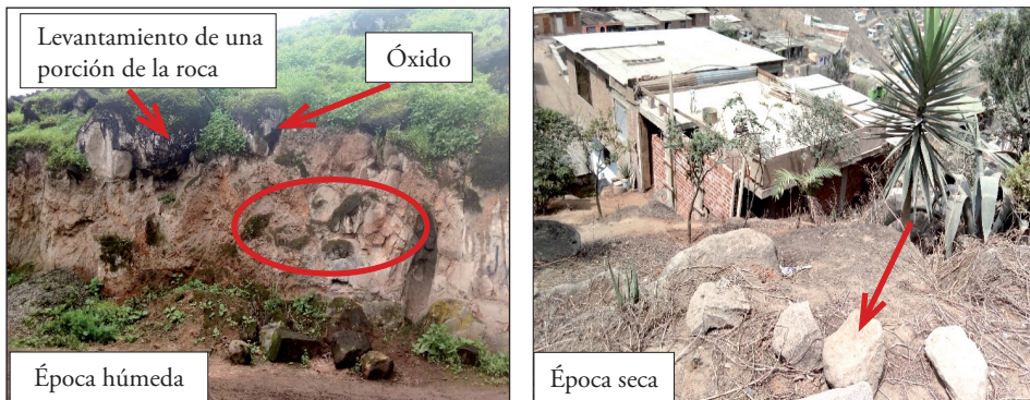
Figura 2. Caracterización de la geología del asentamiento humano Quebrada Alta del Paraíso
