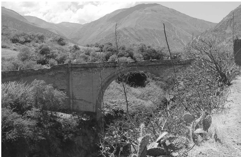
Puente colonial sobre el río Pachachaca – Fotografía: Carmen Mallqui
