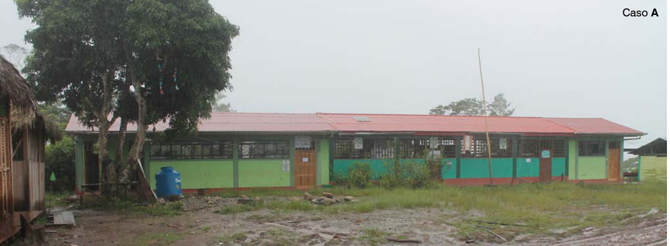
Figura 11: Colegio de primaria. Registro fotográfico del autor (2014).
