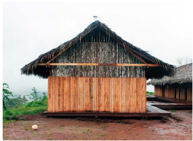
Figura 4: Colegio de secundaria. Registro fotográfico del autor (2014).
