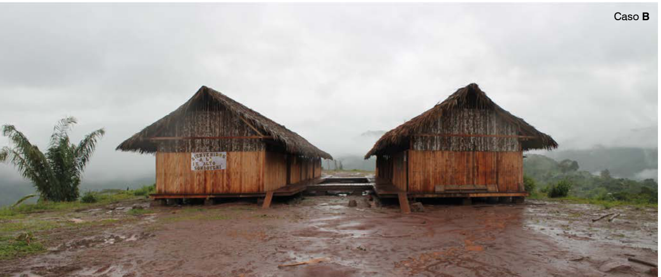
Figura 12: Colegio de secundaria. Registro fotográfico del autor (2014).
