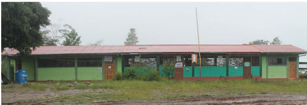
Figura 2: Colegio de primaria. Registro fotográfico del autor (2014).
