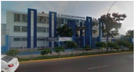
Fachada por avenida La Marina.
