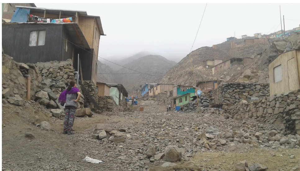
Figura 5. Ladera de tipo rocosa con desprendimientos de roca. Fotografía del autor, 2017.
