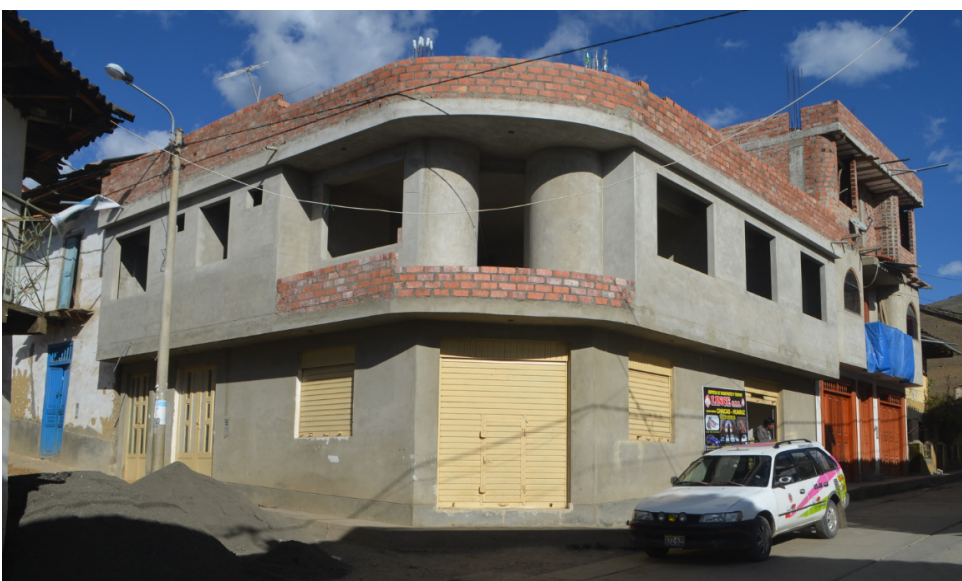
Figura 20. Techo de la fachada moderno-popular. Fotografías del autor, 2015.
