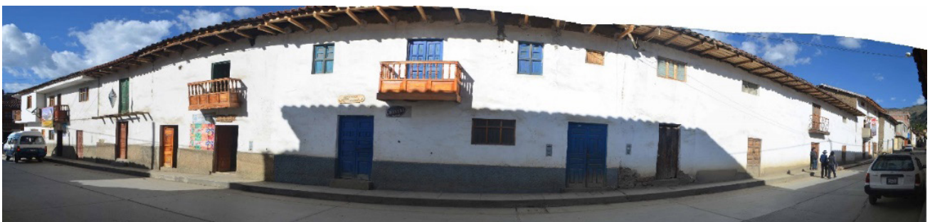
Figura 5. Vista de las fachadas del jr. Buenos Aires. Fotografía del autor, 2015.
