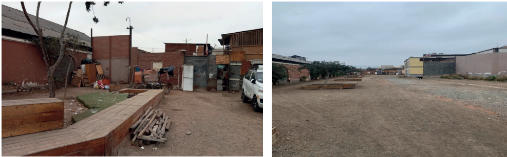
Figura 6. Jirón Tayacaja cuadra 1, lugar del incendio del 29 de julio del 2020 donde 60 familias quedaron desamparadas.
