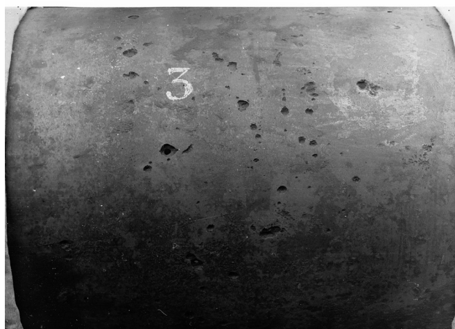
Figura 3. Corrosión por picadura en tubería de acero para agua. Imagen de dominio público (Original de "The History Trust of South Australian, South Australian Government").
